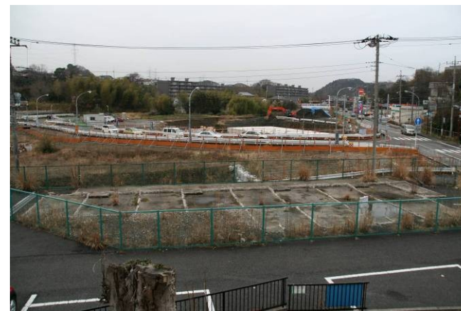
工事中の神戸橋付近 神戸橋付近から北方向
