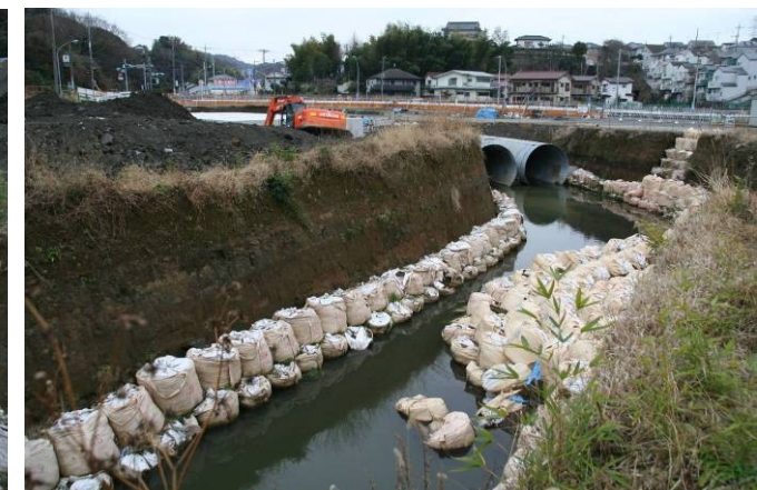
川窪に出来たバイパス河川 上左が神戸橋。 この溝は埋められ、パイプと直線方向に流す。
