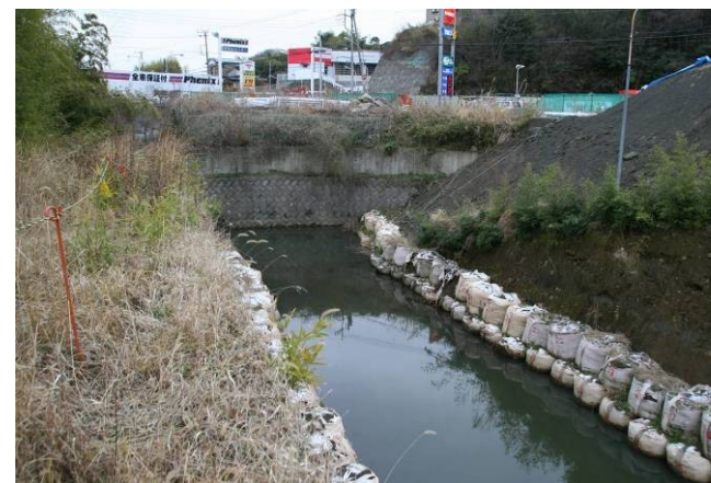
バイパス河川が奥で旧河川と交わる。 上右方向が土砂で埋められた川窪。
